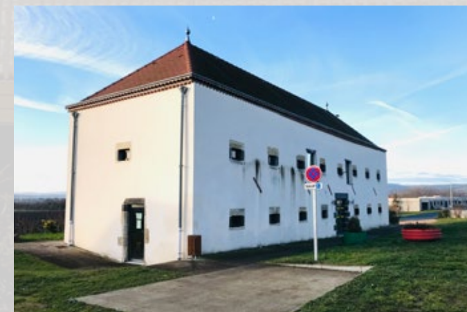
Bâtiment dit «Les Écuries» à la Moutade
